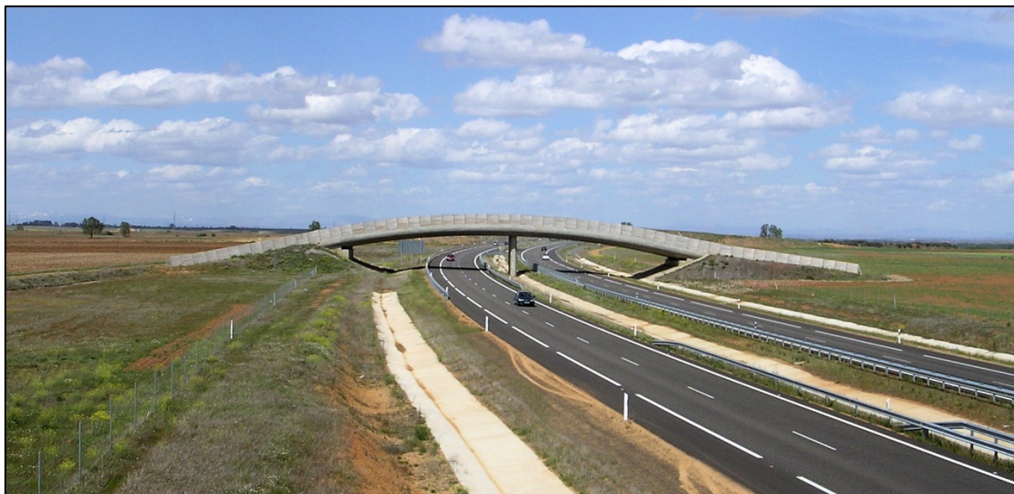
Figur 21. Ekodukt längs A66, en motorväg i nordvästra Spanien. Denna ekodukt är byggd i ett flackt landskap där vägen ligger i ungefär samma nivå som omgivande marker. Photo: Cristina Mata, (UMA - Universidad Autonoma de Madrid).
