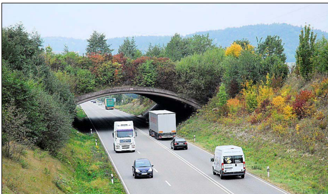
Figur 18. En ekodukt är en grön korridor över väg och järnväg. Foto från Tyskland, Überling. Foto: Mats Lindqvist.
