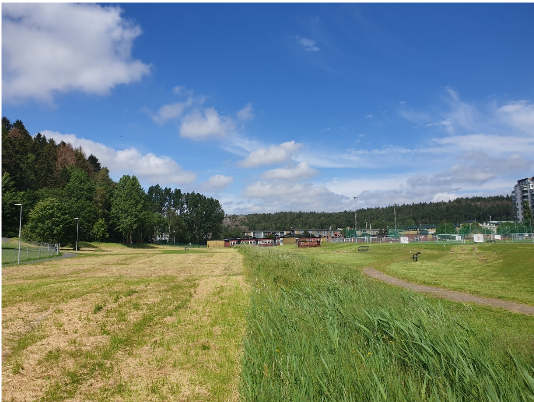
Figur 25. Befintlig avskärande anläggning för markavvattning i planområdets sydvästra park i sommartid.
