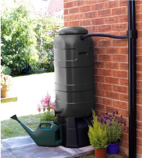
Figur 31. Exempel på vattentunna kopplad till stupröret för att dagvattnet ska kunna användas som en resurs (foto: GreenLine).
