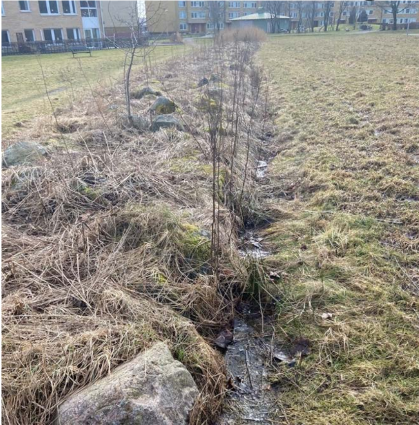
Figur 24. Befintlig avskärande anläggning för markavvattning i planområdets sydvästra park vintertid.
