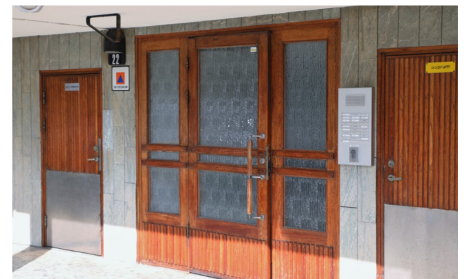
Entrépartier med dörrar av trä och glas.
