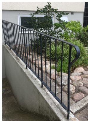
Tidstypiskt staket av järn.
