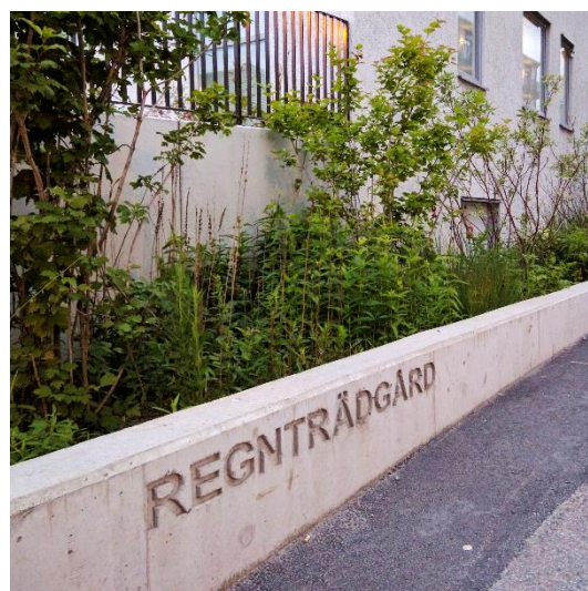
Figur 15 Exempel på utformning av biofilter utmed huskropp. (Sett från vänster: Hammarbysjöstad i Stockholm; Kvillebäcken i Göteborg. Bildkälla: Sweco).
