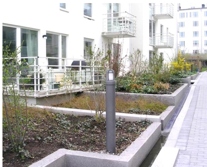
Figur 15 Exempel på utformning av biofilter utmed huskropp. (Sett från vänster: Hammarbysjöstad i Stockholm; Kvillebäcken i Göteborg. Bildkälla: Sweco).
