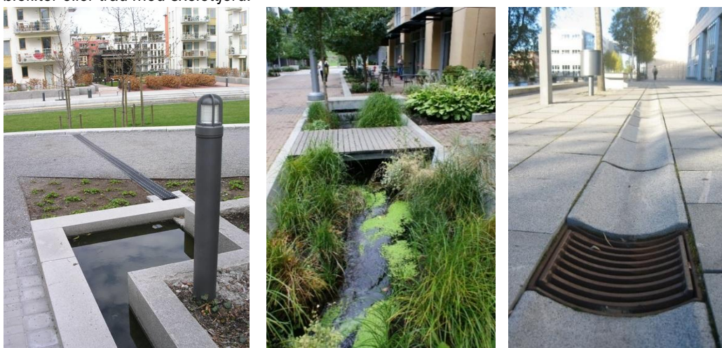
Figur 16 Skiss utformning av en gränd. Förgårdsmark utmed husväggen kan brukas till fördröjning och rening av takdagvatten i biofilter. Dagvatten från gränderna kan fördröjas i flexibelt fält i t.ex. biofilter eller träd med skelettjord.
