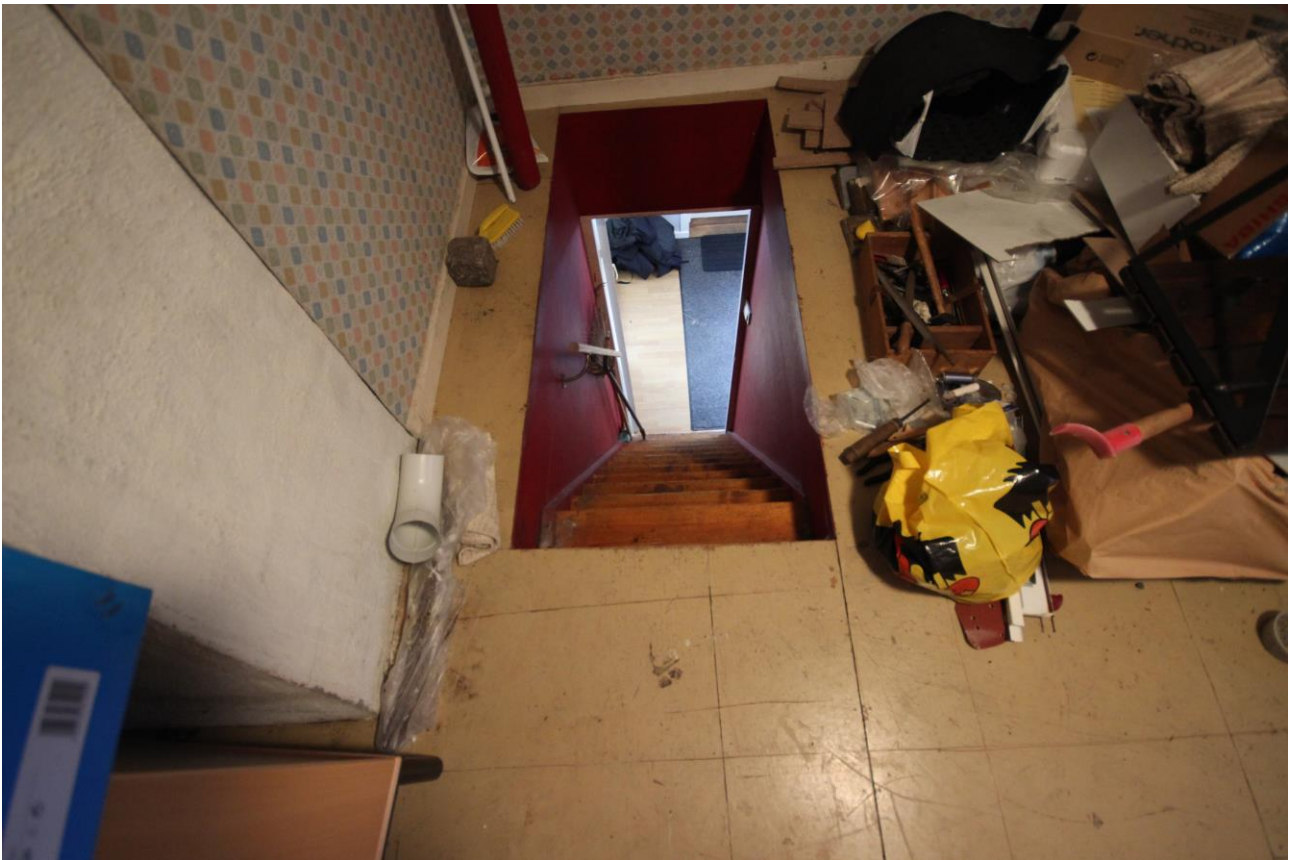
Den enkla trätrappan upp till den inredda vinden.
