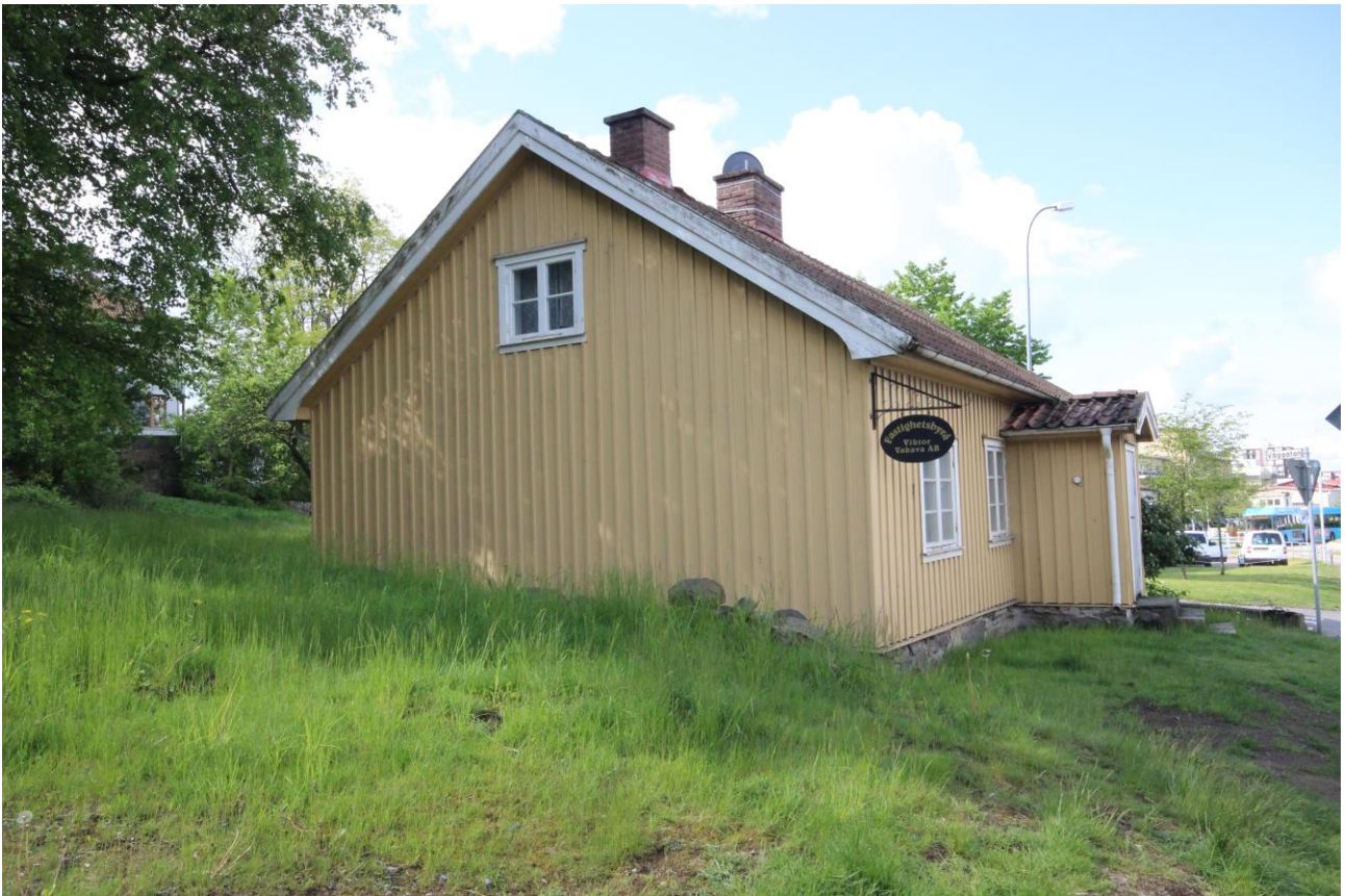
Fasad mot öster samt del av norra fasaden.
