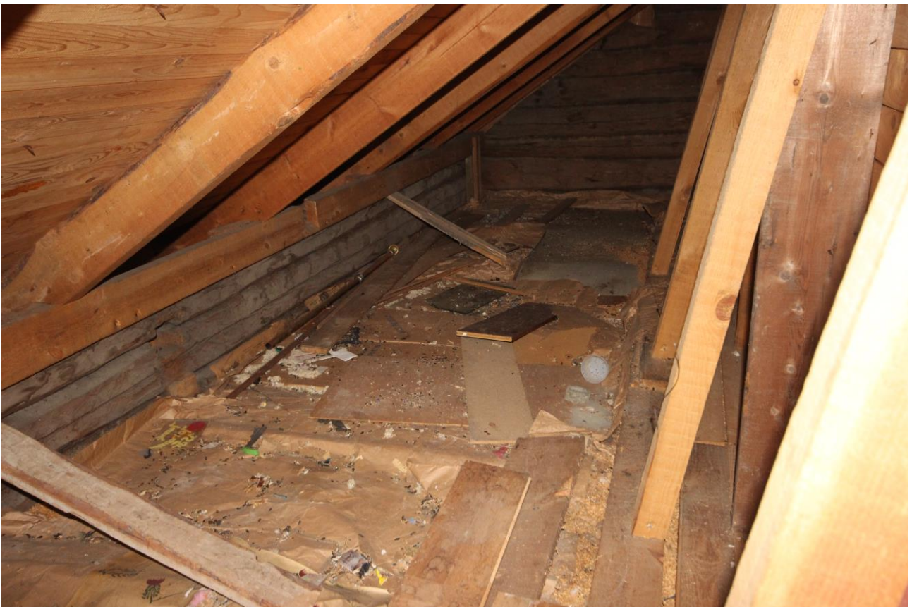
Kattvind orienterad mot norr. Ytterväggarnas timmerstomme är här synlig. Takstolen samt undertaket bedöms senare tillkomna relaterat timmerväggarna.
