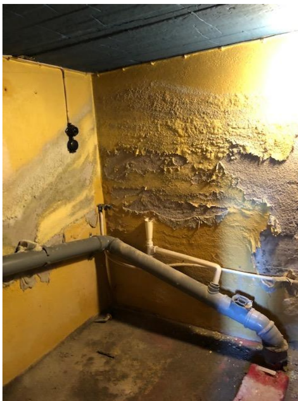
Även större delen av taket samt golvet är gjutet.
