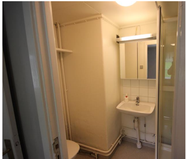
Västra murstocken är synlig i WC-utrymmet.
