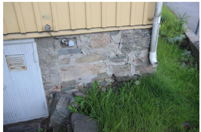
Huset står på en stenfot av fogad och huggen/klyvd natursten. Mot väster – där källardelen finns – är stenmuren högre. Sockeln är original/äldre.
