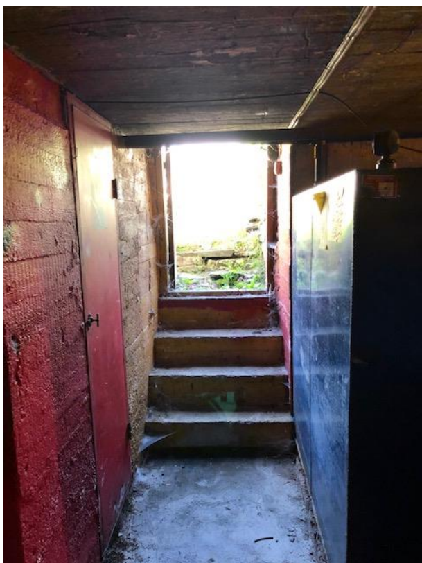
Vy mot källaringången. Den invändiga delen av trappan är gjuten, liksom väggarna.
