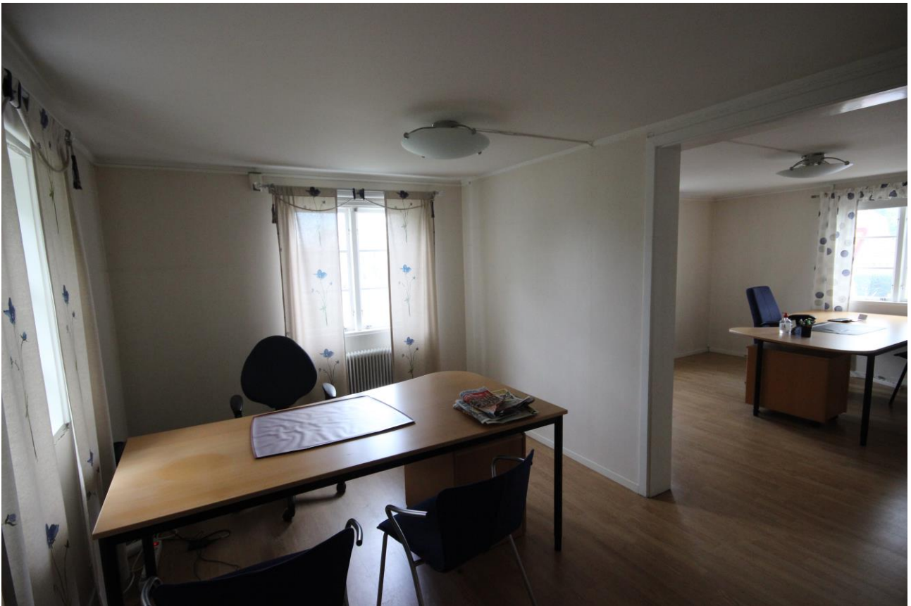
Rum i byggnadens västra del. En större dörröppning har tagits upp i väggen mellan rummen. Så gott som samtliga väggpartier bedöms vara äldre.
