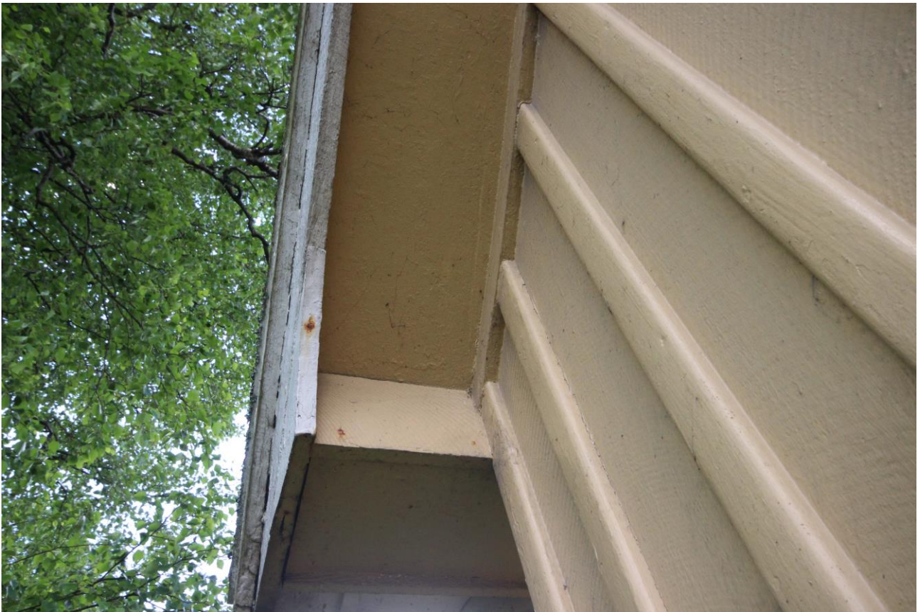
Taksprångens undertak är klädda med masonitskivor.
