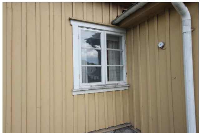
Fönstren utgörs övervägande av tvåluftsfönster med liggande spröjs – samtliga är sekundära.
