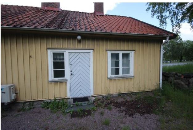
Södra fasadens entré. Entrédörrarna är sent tillkomna medan källardörren är något äldre.
