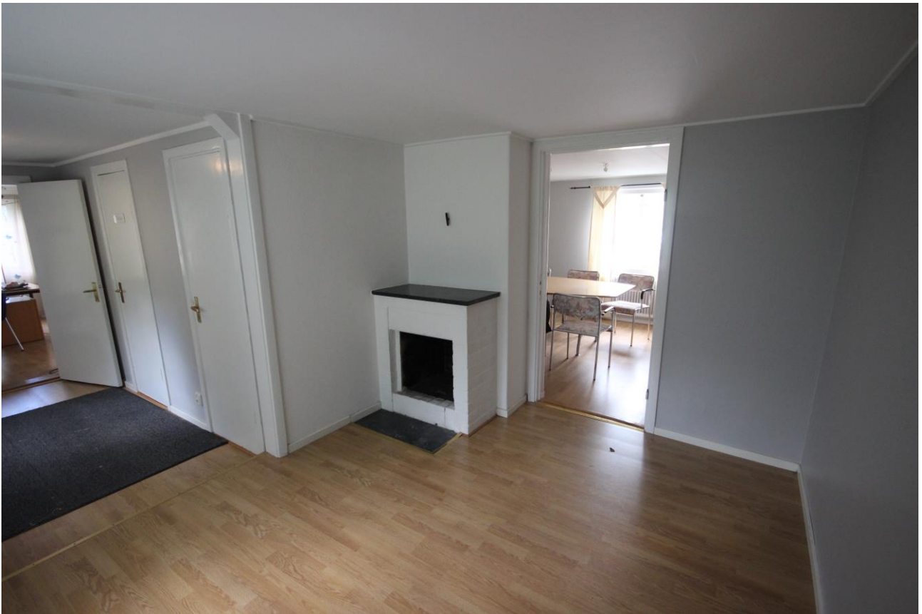
Ytskikt och detaljer är sekundära. Den öppna spisen bedöms vara från omkring 1940-talet. Skorstensmuren är dock äldre.
