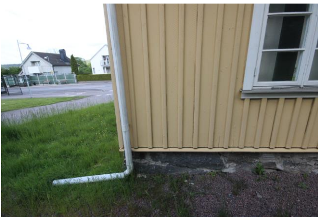
Samtlig panel bedöms vara utbytt och ingen äldre panel finns bevarad. En stor del av panelen är cirkelsågad och märkena efter sågklingan är tydligt avläsbara.
