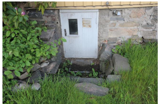
En äldre stentrappa med stenklädda sidor till källaren.
