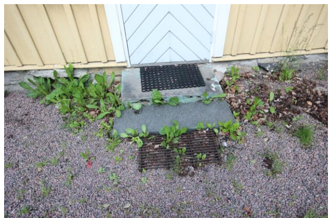
Ett gjutet trappsteg samt ett nedre steg av natursten – sekundära delar.
