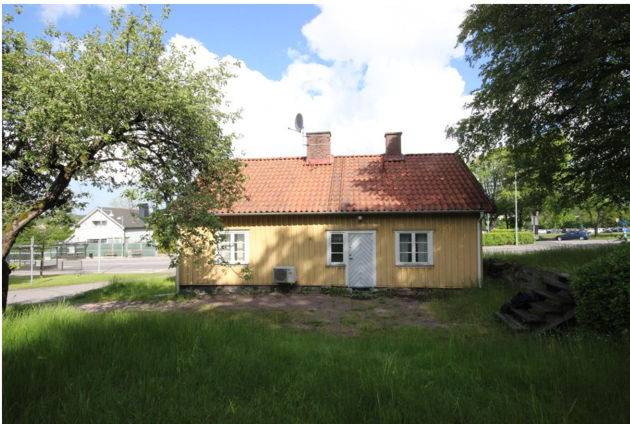
Fasad mot söder. Här fanns förr ytterligare en farstukvist.
