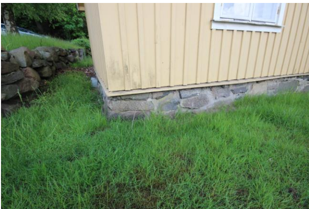
Huset står på en stenfot av fogad och huggen/klyvd natursten. Mot väster – där källardelen finns – är stenmuren högre. Sockeln är original/äldre.
